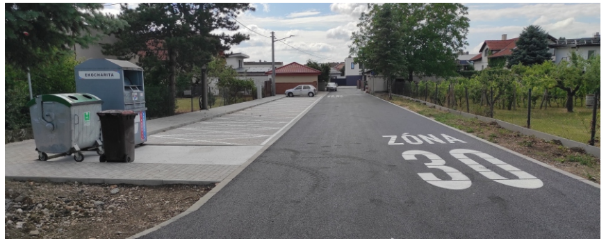
Zelená ulica – pred a po rekonštrukcii
