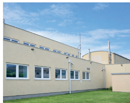
Výmena okien na budove SLSP - vizualizácia
