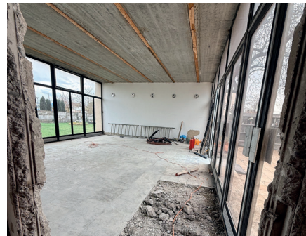
Dom smútku - rekonštrukcia
